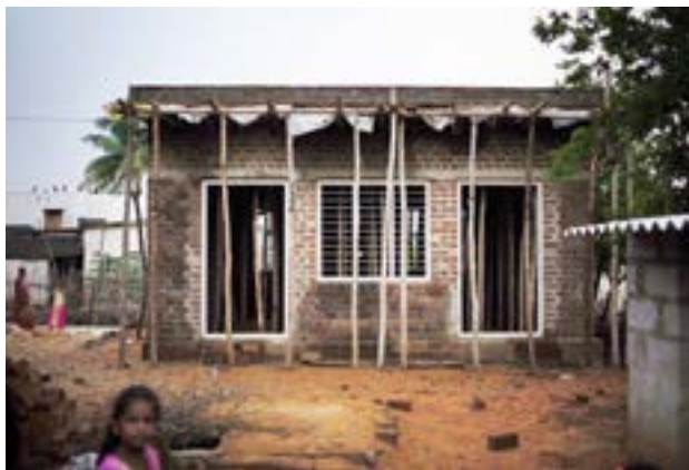
Rohbau des ersten Studienzentrums.
